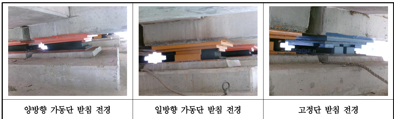
【사진 39.3.12】 교량받침 전경
