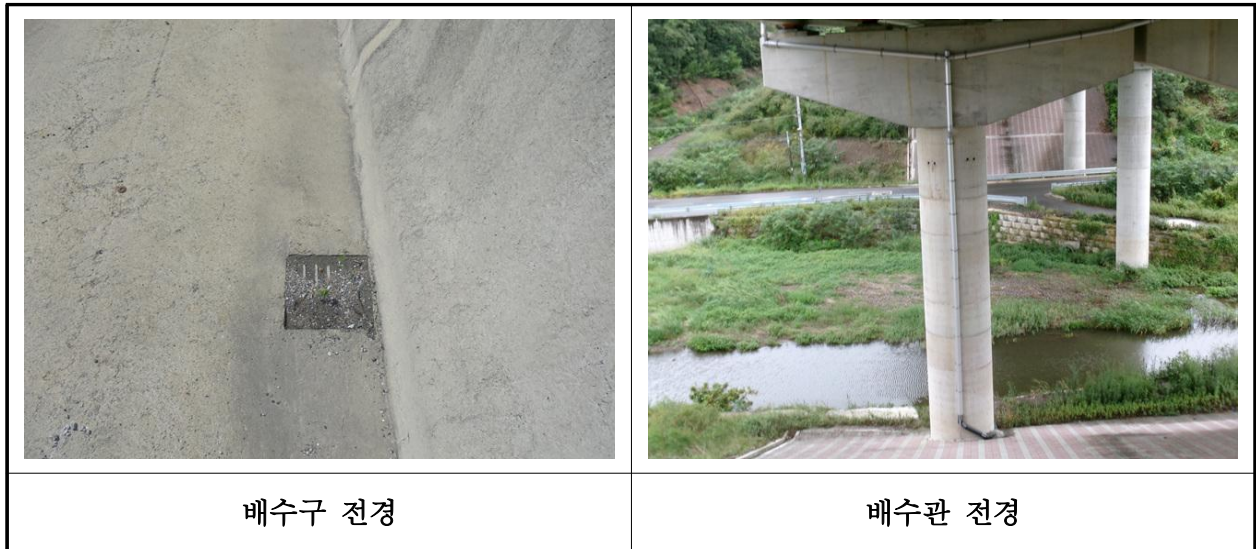
【사진 39.3.46】 배수시설 전경
