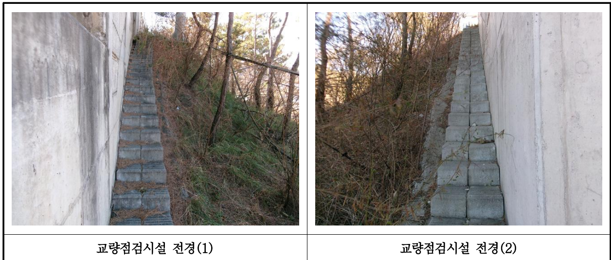
【사진 39.3.25】 교량 점검시설 전경
