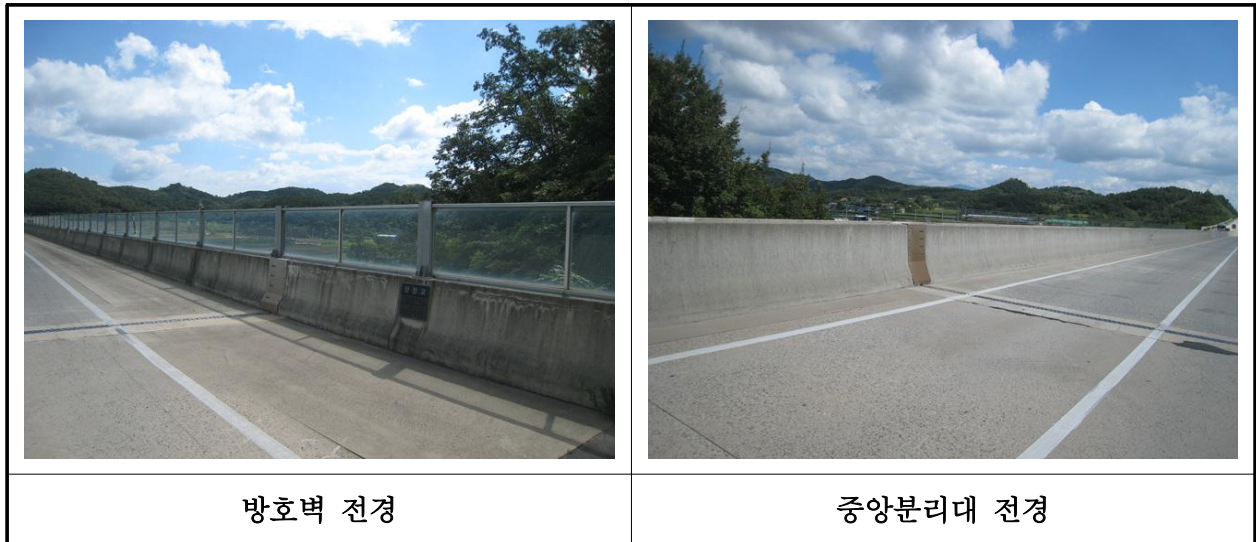
【사진 39.3.48】 방호벽 및 중앙분리대 전경
