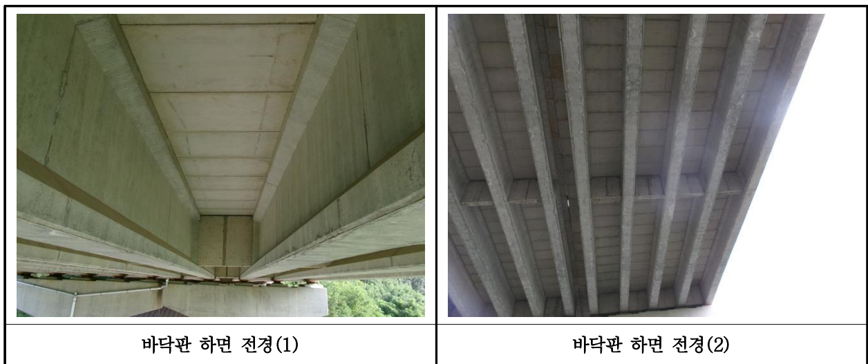
【사진 39.3.2】 바닥판하면 전경
