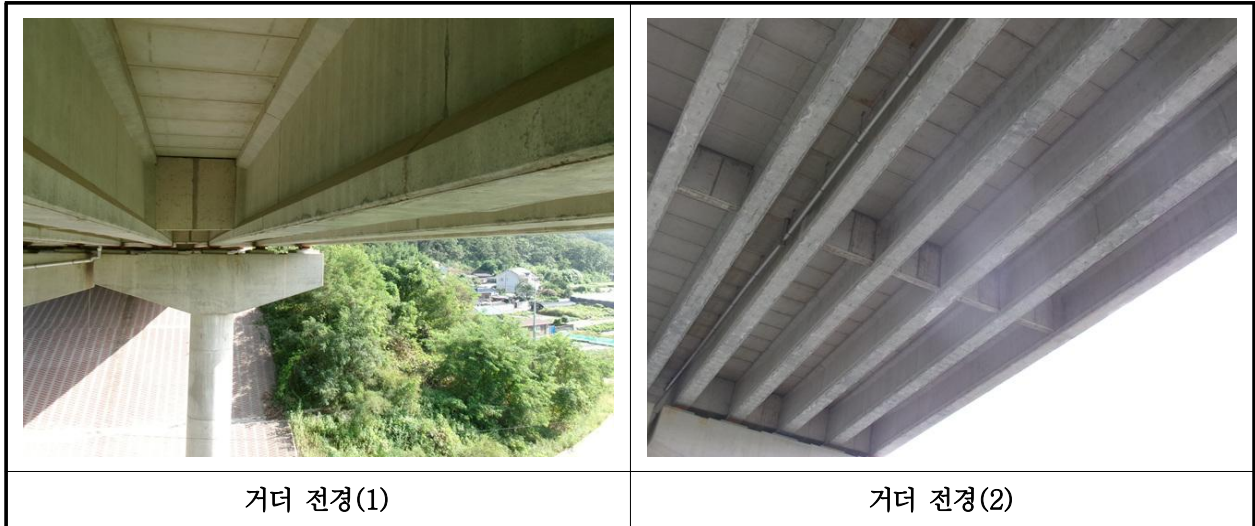
【사진 39.3.4】 거더 전경
