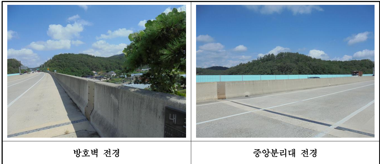
【사진 39.3.23】 방호벽 및 중앙분리대 전경
