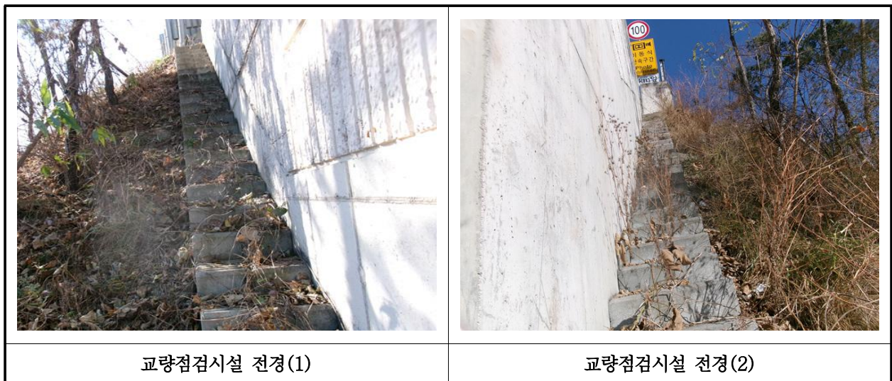
【사진 39.3.50】 교량 점검시설 전경
