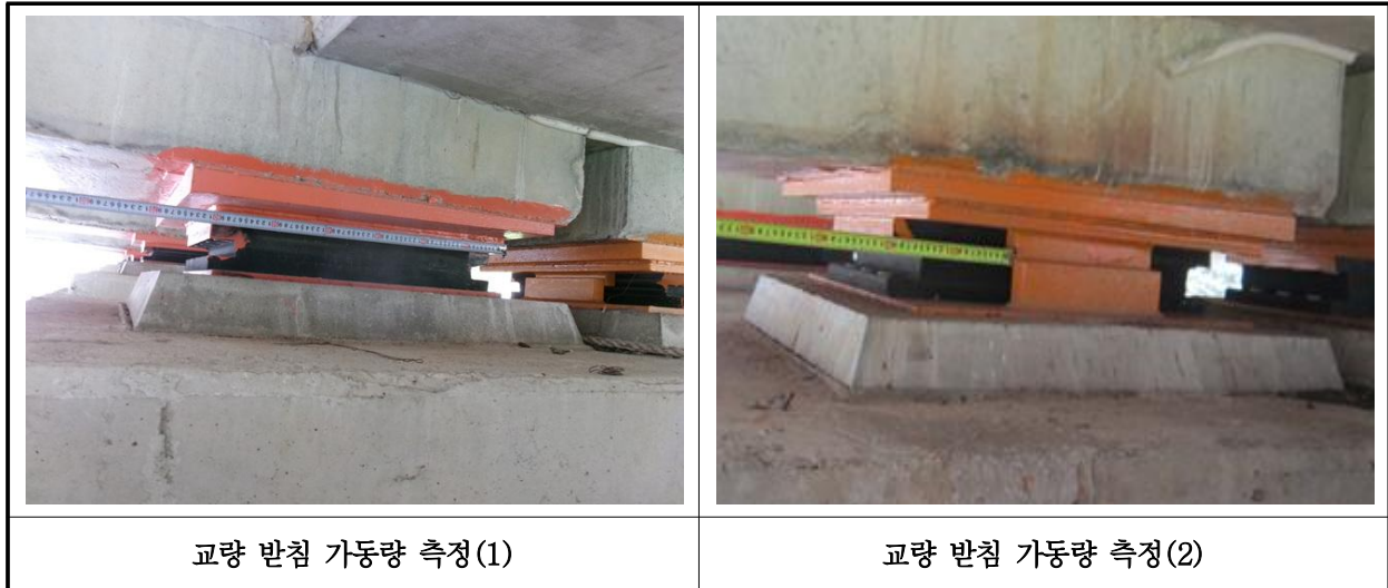
【사진 39.3.40】 교량받침 이동량 상태
