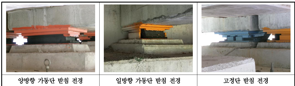
【사진 39.3.37】 교량받침 전경
