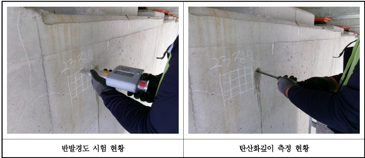
【사진 39.4.1】 콘크리트 내구성조사 현황
